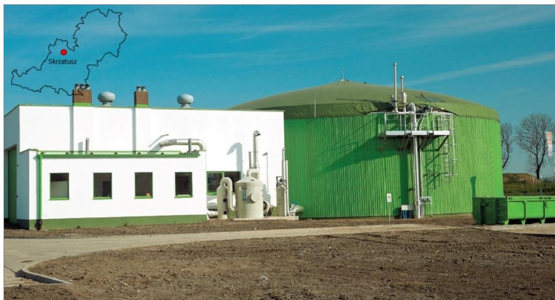
Rysunek 9 Elektrociepłownia biogazowa w Skrzatuszu.
