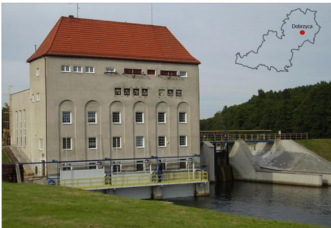
Rysunek 10 Elektrownia wodna w Dobrzycy.
